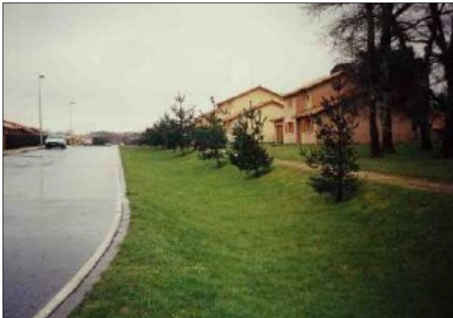
Noue le long d'une voie créant un habitat naturel aéré. Source : CETE du Sud-Ouest
