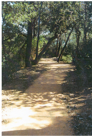
Exemple de chemin en stabilisé.
