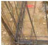
Noeud de chaînage - Continuité mécanique
