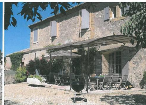
Vue de la façade Sud du corps principal et vue de détails de l'arrière du bâtiment principal. Ces photos montrent les matériaux existants
