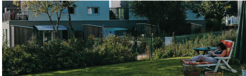
Exemples d'accès aux logements par le jardin principal.
