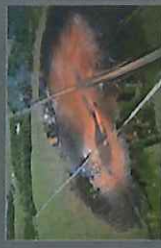
Conséquences d'une fuite sur une canalisation de transport. Appomattox (USA), 14 septembre 2008 (source: pastus.org).
