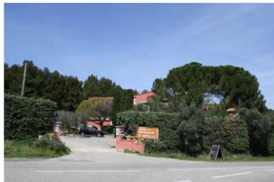
- Constructions au droit du carrefour RD 17 / RD 78f
