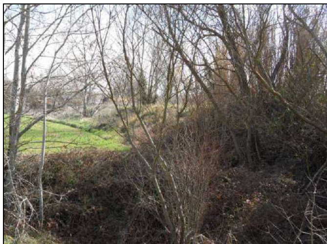
D. Les Milles – digue de protection d'une habitation
