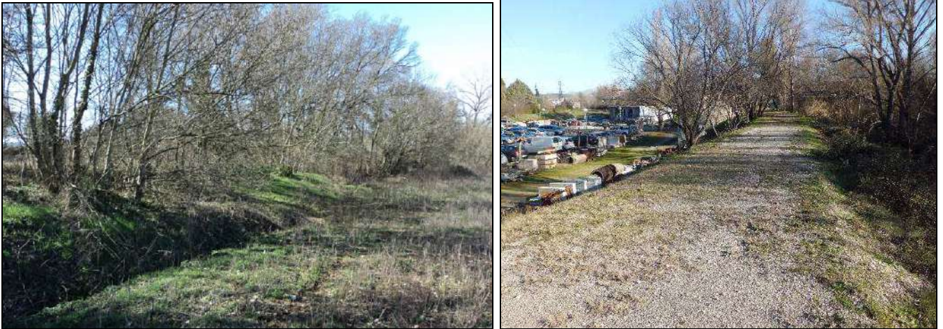
J. Trets : en aval immédiat de l'autoroute
