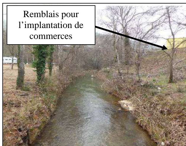
Figure 8 : Exemple de remblai en lit majeur sur le secteur de Meyreuil/Tholonet
