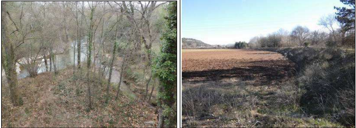
Photos à Meyreuil : gauche : confluence Arc/Bayeux – droite : digue de Bachasson
