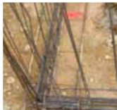
Noeud de chaînage - Continuité mécanique
