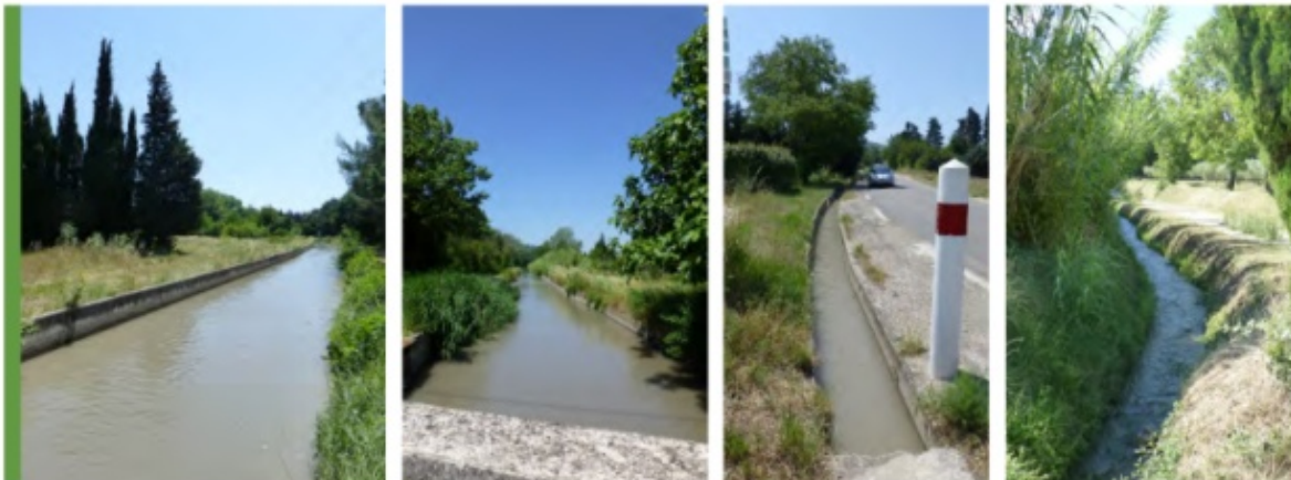
1 - Canal vu depuis la D24 / 2 - Canal passant sous le chemin de Cantos / 3 - Filiole maçonnée le long de la D24 / 4 - Filiole en tranchée chemin du Cèbe.
