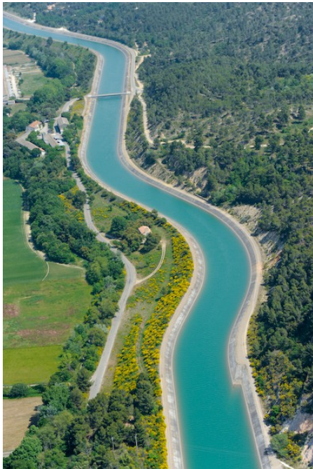
Photos du canal EDF
