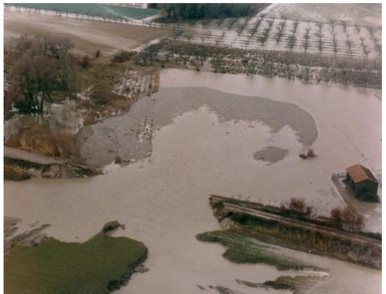
Exemples de dégâts provoqués par des ruptures d'ouvrage : Maison du garde-digue à Fouques en décembre 2003 (à gauche) Rupture de l'Epi de Basse Plaine à la Roque d'Anthéron lors de la crue de janvier 1994 (à droite)
