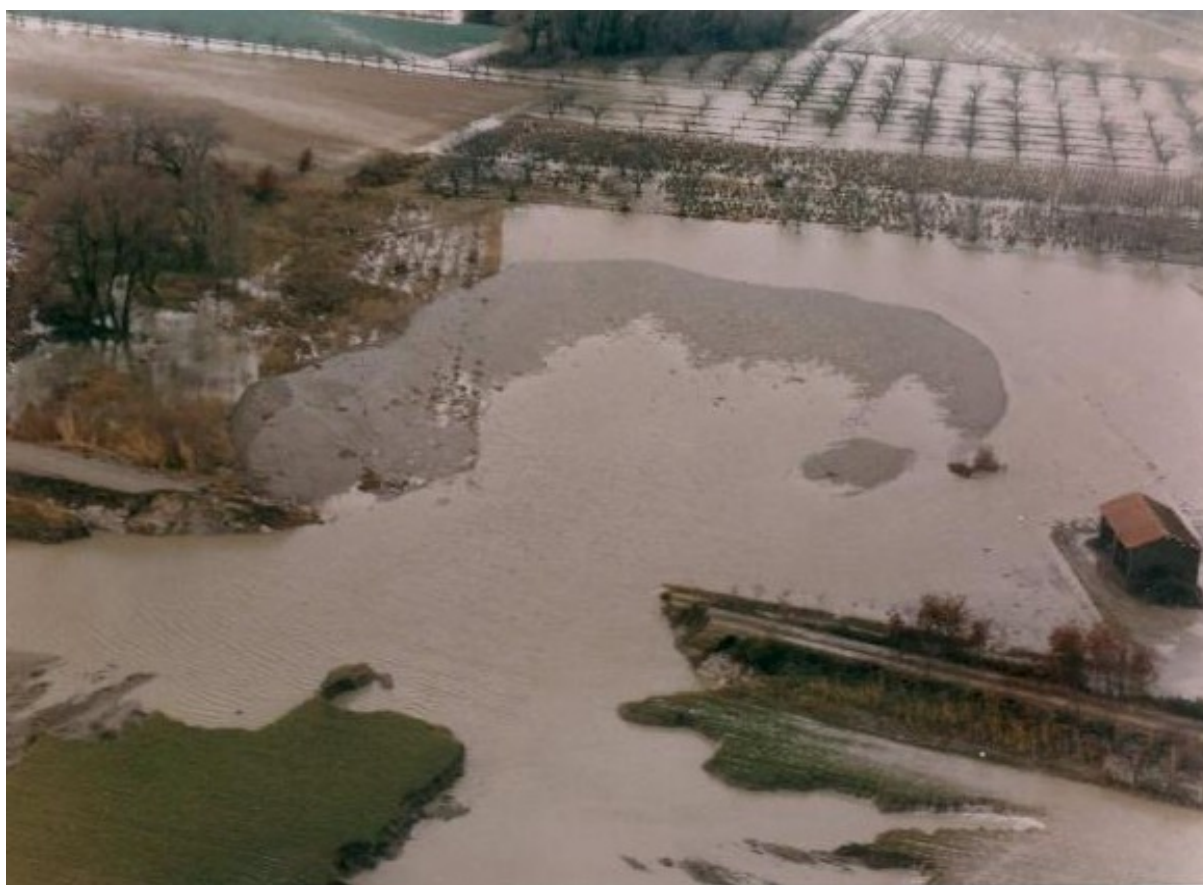
Rupture de l'Epi de Basse Plaine à la Roque d'Antheron, crue de Janvier 1994
