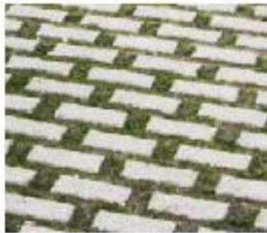
Pavage en béton avec ouvertures de drainage
