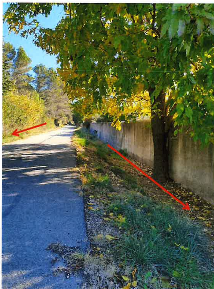
Image 21 : Fossé du Mas d'Auge limité par le mur d'enceinte du Mas Vinaigre (à droite) et arrivée d'un talweg sur chemin coupant le secteur de Machotte nord-sud (à gauche)
