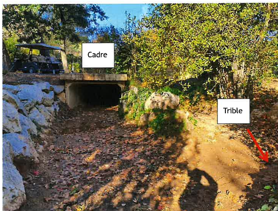
Image 24 : Cadre béton en siphon rejoignant le vallon du Tribble en aval de l'accès au parking
