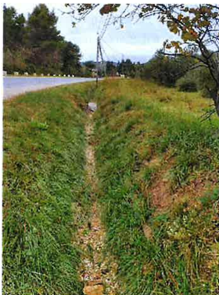
Image 9 : Dépôts sédimentaires dans le fossé de la route de Saint-Rémy (à gauche) et dans le vallon de Vaupelière (à droite) à proximité de la route de Saint-Rémy
