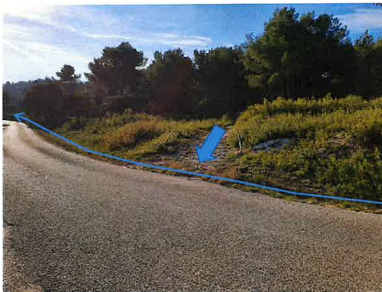
Image 2 : Axe de ruissellement depuis le chemin drainé par le fossé de la route menant de la RD13 au golf
