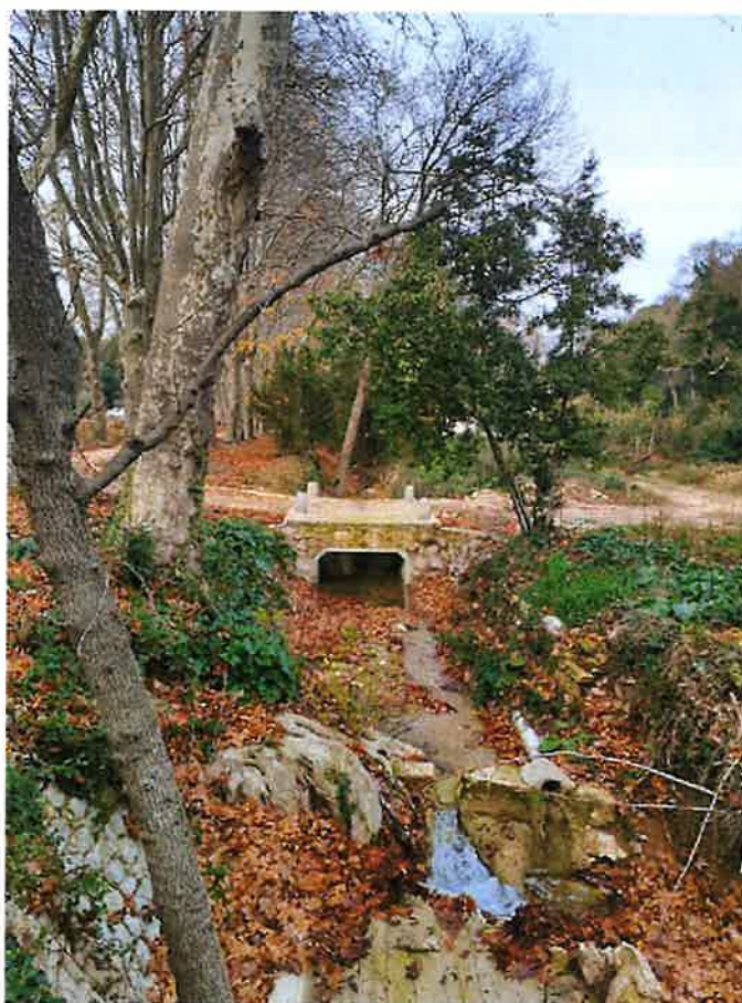
Image 5 : Tribble canalisé sur le parking de Manville (exutoire du Bassin-versant)
