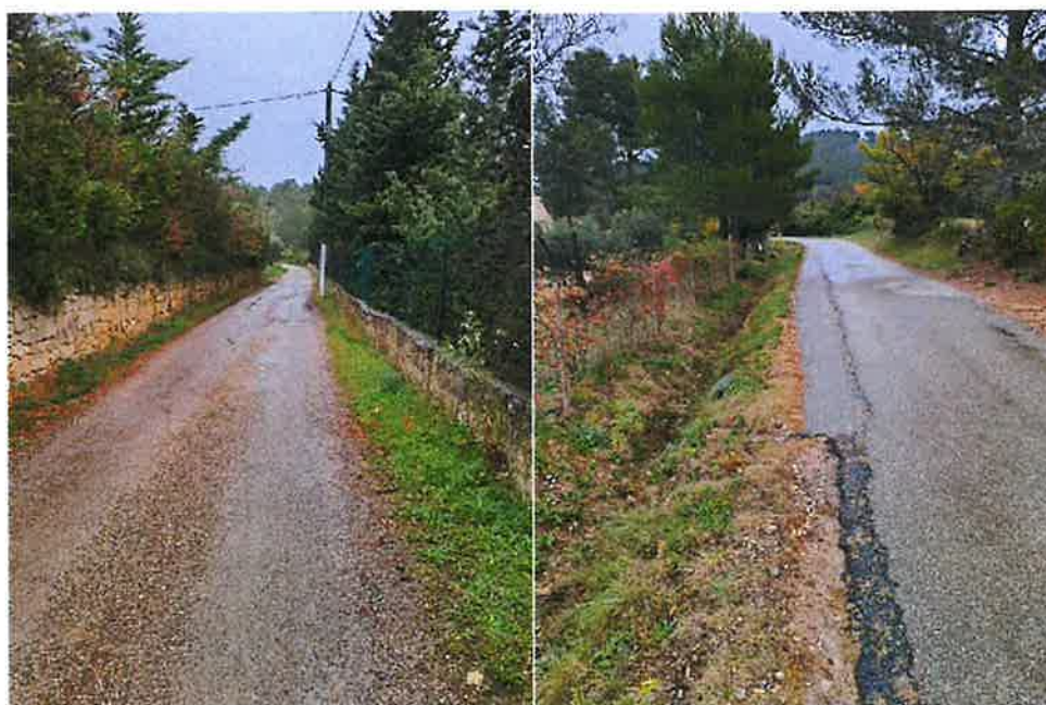
Image 17 : Route servant d'axe d'écoulement (à gauche) fossé limitant les eaux amont (à droite)
