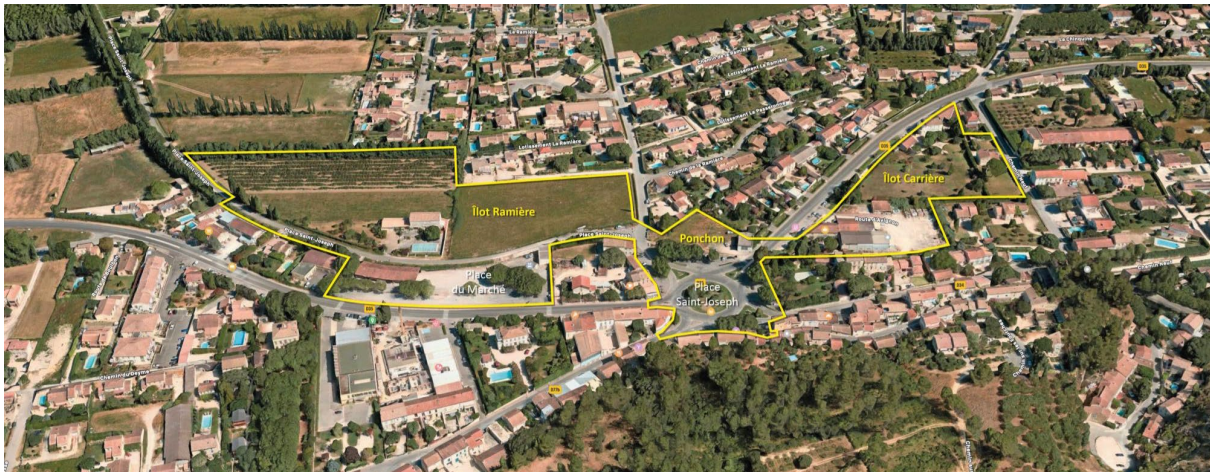
Vue aérienne sur le site
