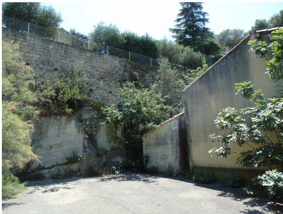
Figure 12: Exemple d'escarpement surmonté par un mur de soutènement.
