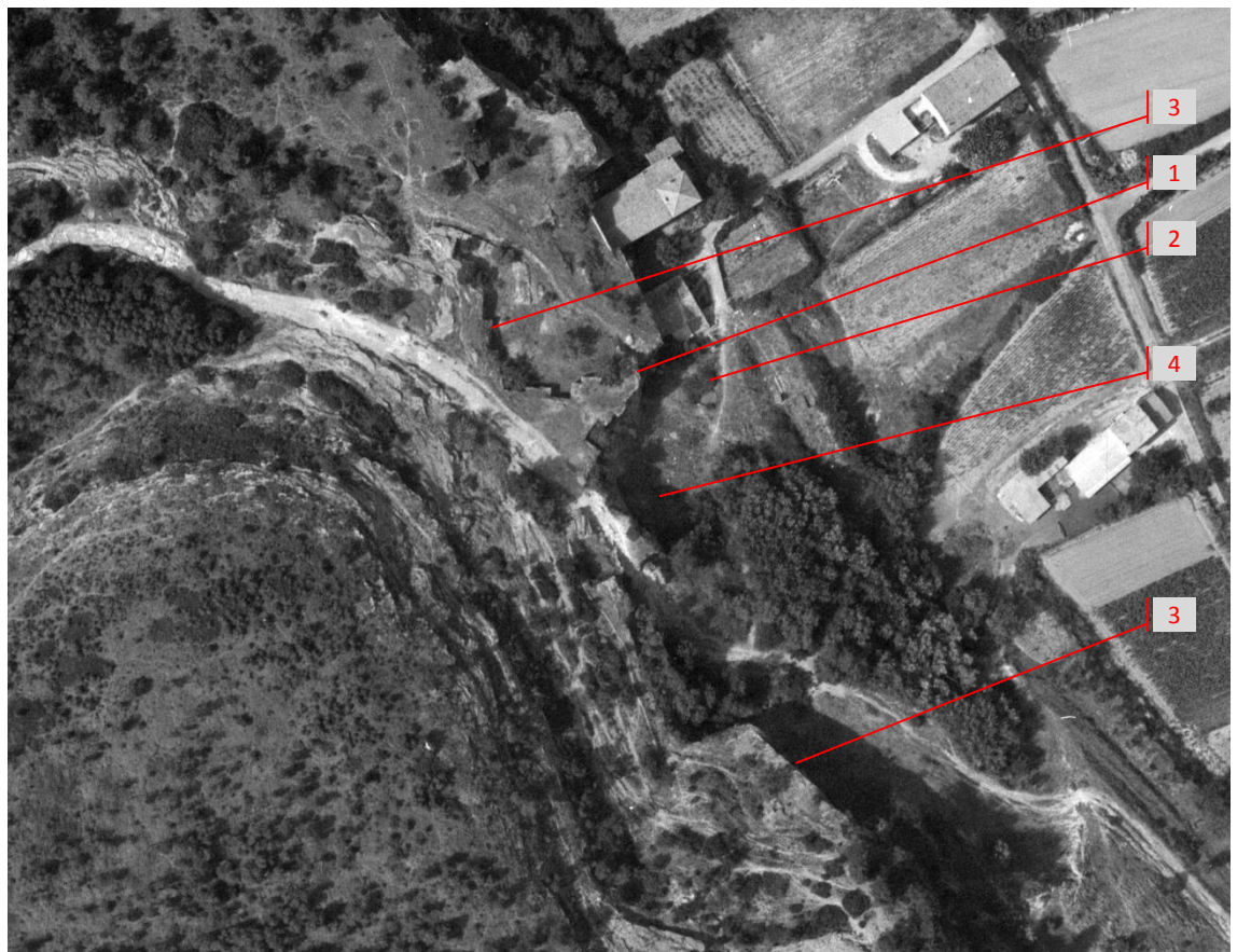
Figure 4 – Extrait d'une photographie aérienne de 1964 [13]. 1 : emplacement approximatif de la parcelle BW 370 - 2 : masse instable n°1 – 3 : état des fronts identique à la situation actuelle – 4 : zone d'excavation au droit des parcelles BW 368-369 (Nord en haut de l'image)
