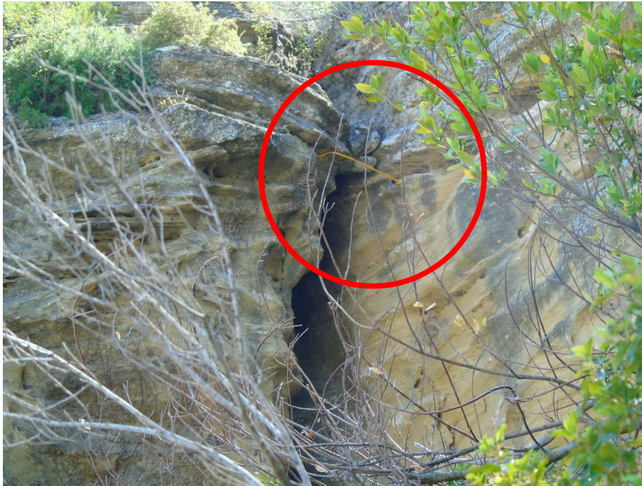
Figure 15: Un fissuromètre installé sur le pilier du Petit Castel.
