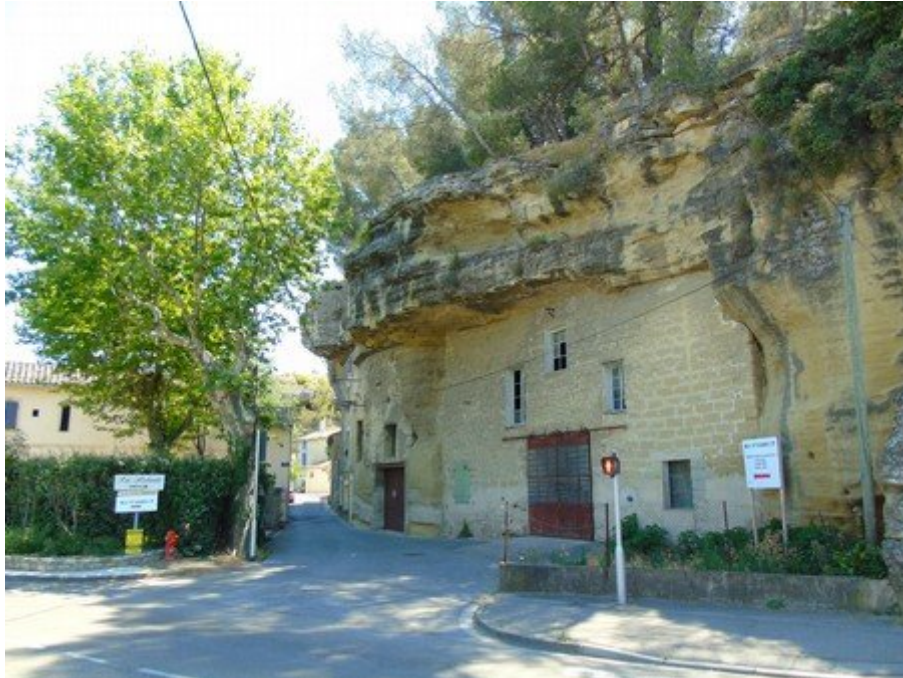
Figure 10: Exemple d'habitat troglodyte à Barbentane. La hauteur est d'une quinzaine de mètres.
