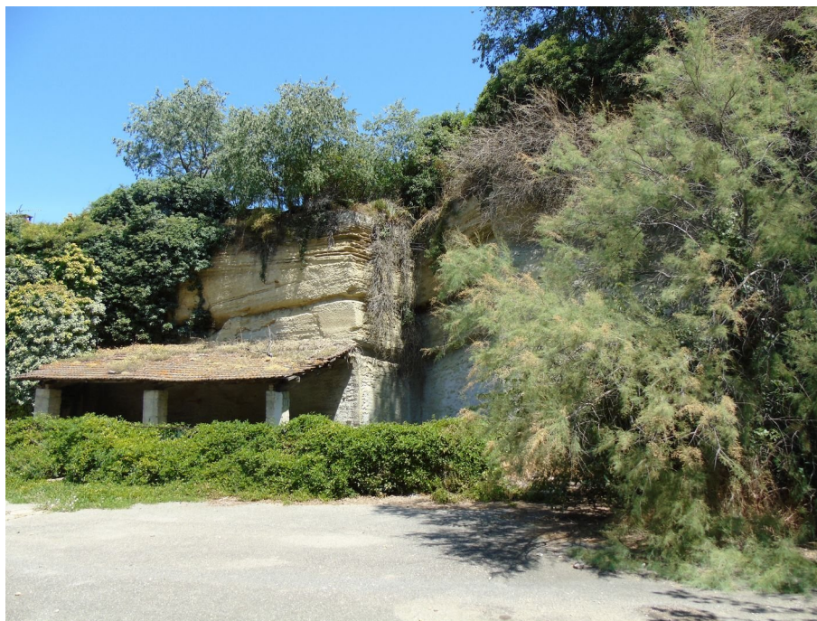
Figure 11: Exemple d'escarpement rocheux surmontant un soubassement en maçonnerie.
