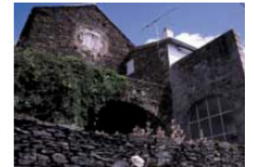
Extension d'un bâti ancien
