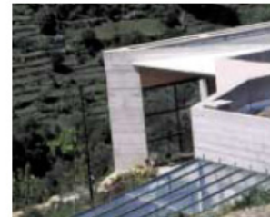
Maison et béton brut
