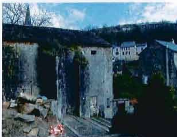
Contreforts de l'église - Saint-Léons
