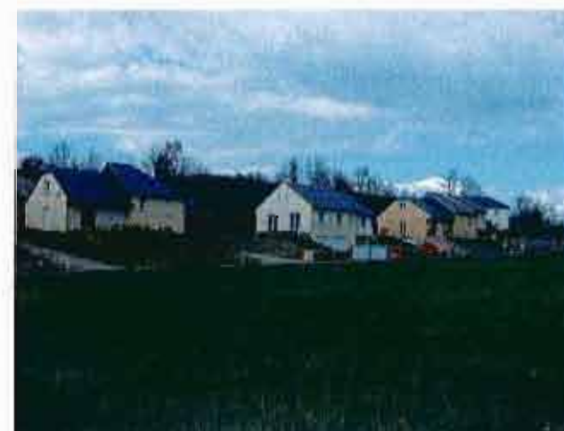
Lotissement Les Combes de la Valette : voirie en impasse
