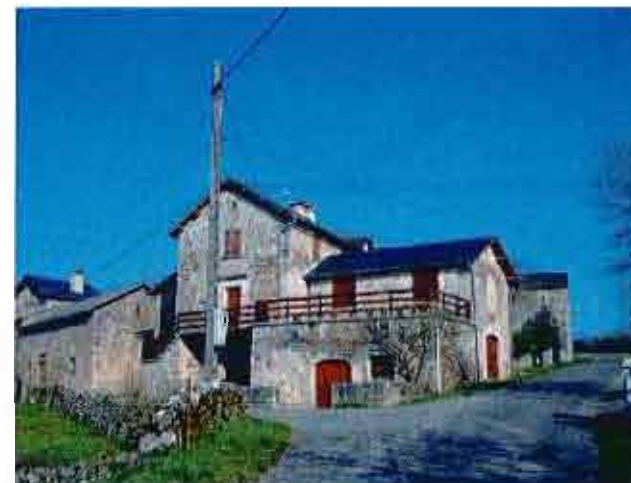
Bâti traditionnel bien entretenu
