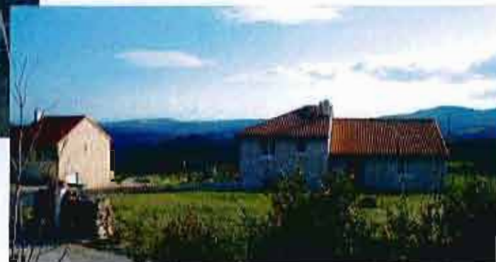
Nouvelles constructions - Bouscayrols
