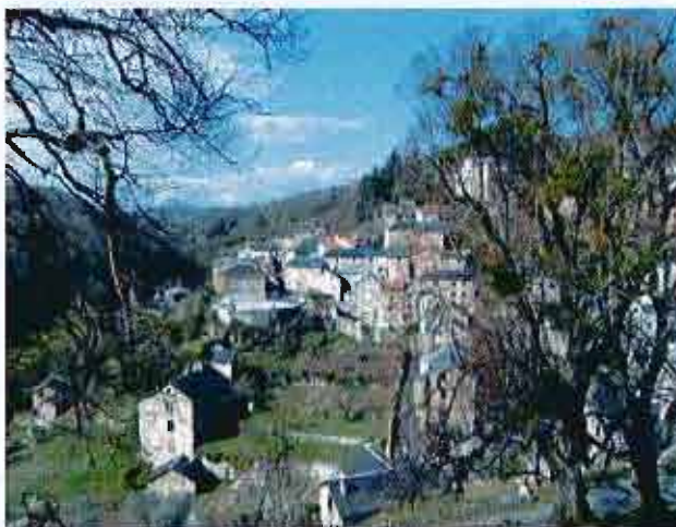
Vue sur le bourg et les jardins en terrasse notamment au Sud du bourg
