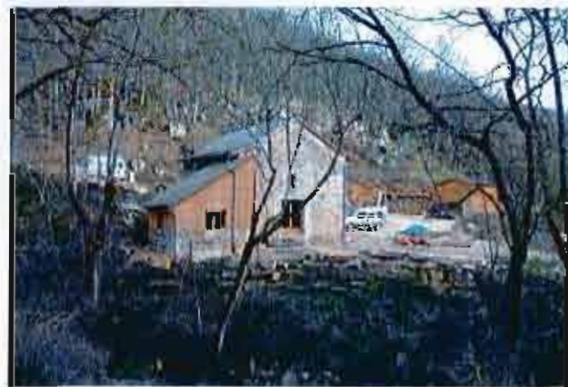
Nouvelles constructions - vallée de la Muse
