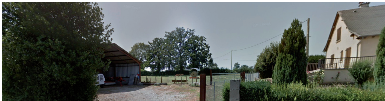
Vue sur le secteur 2 à partir de la voie communale de la Calsigue (Source : Google Street View)
