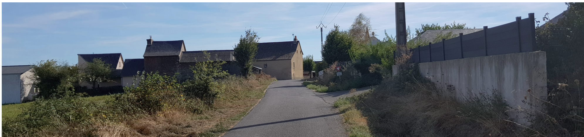
Vue sur le secteur 4 à partir de la voie communale n°13
