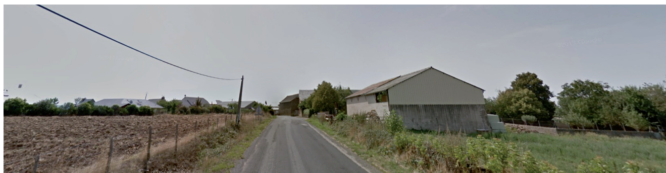
Accotements à aménager pour qualifier l'entrée nord du bourg de Sainte Juliette (Source : Google Street View)
