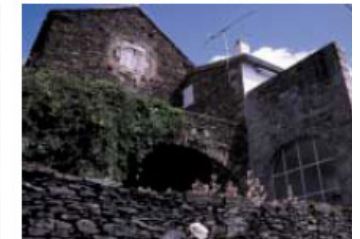
Extension d'un bâti ancien
