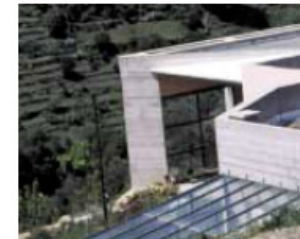
Maison et béton brut
