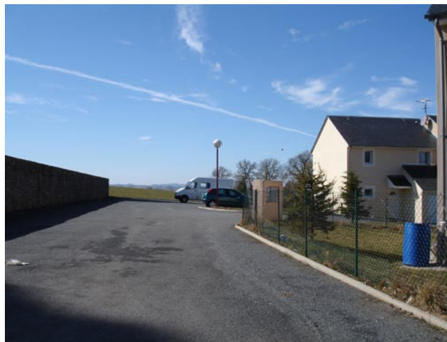
Voirie d'accès depuis le lotissement HLM (entrée en sens unique)
