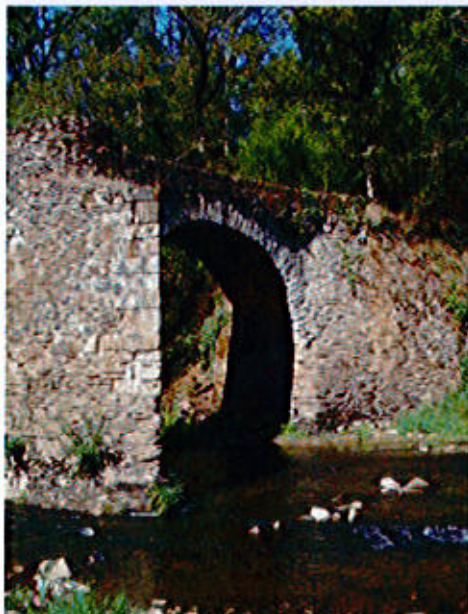
Pont de Comencau (source SDAP-TR)
