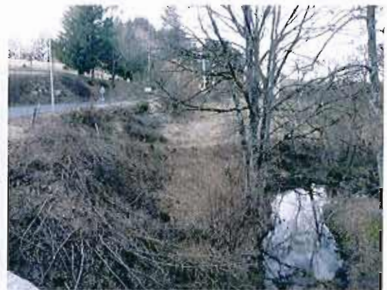
entrée sud du bourg, le Gouzou sur le plateau
