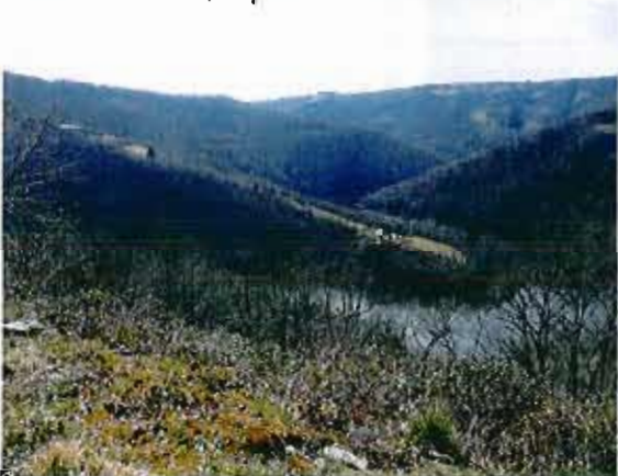
Vue vers l'aval, depuis la rive droite
