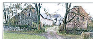
Bâti ancien à réhabiliter
