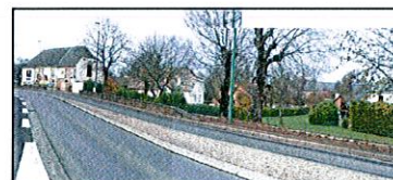
Aménager les axes de circulation pour améliorer la circulation piétonne et cycliste
