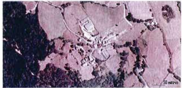
VUE AERIENNE DE LA COURSIERE
