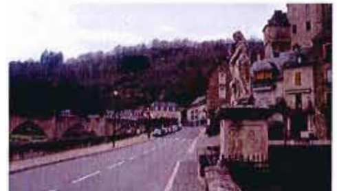
TRAVERSEE DE LA RD 920
