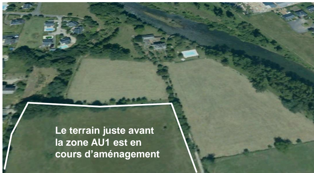
Vue aérienne de la zone depuis l'Est
