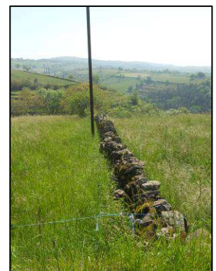
Mur de pierres sèches, limite de parcelles
