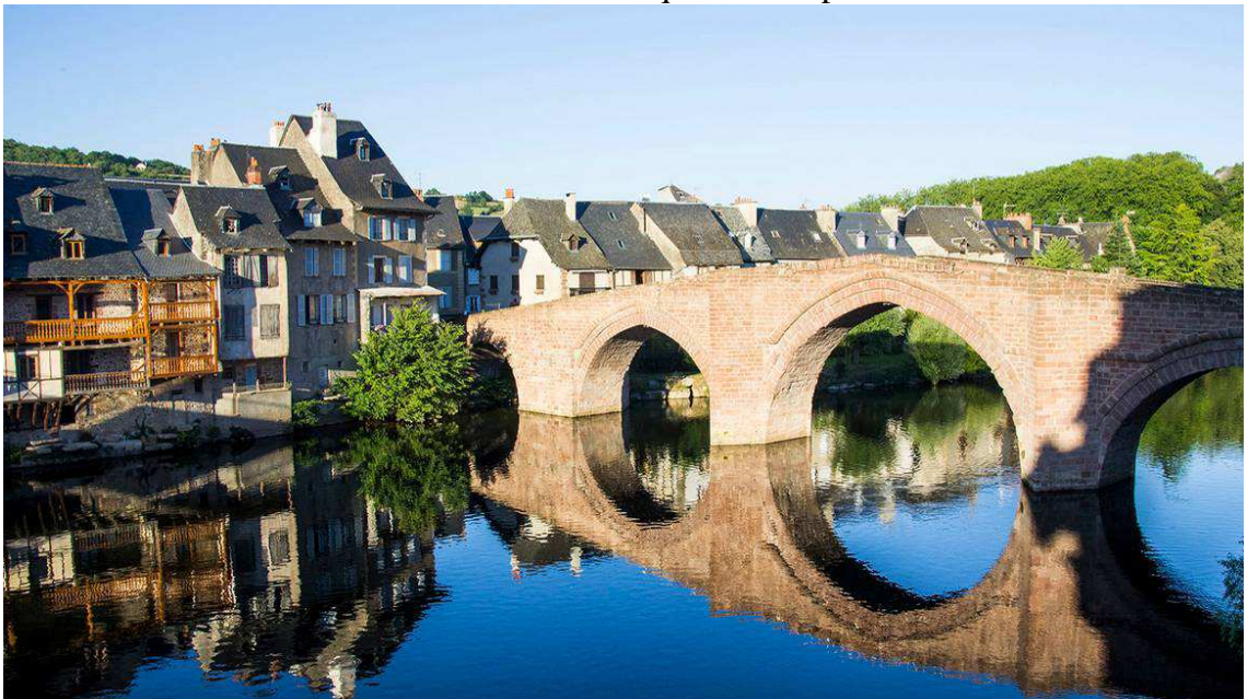
Le Pont vieux et les Calquières à Espalion
