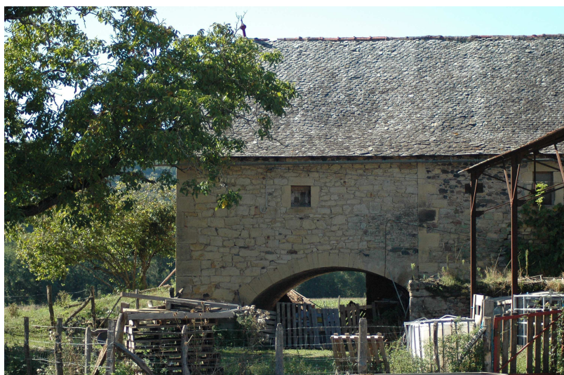
Cette grange étable, perpendiculaire au lit majeur du Lot, présente un porche destiné à favoriser l'écoulement de l'eau en cas de crues.
