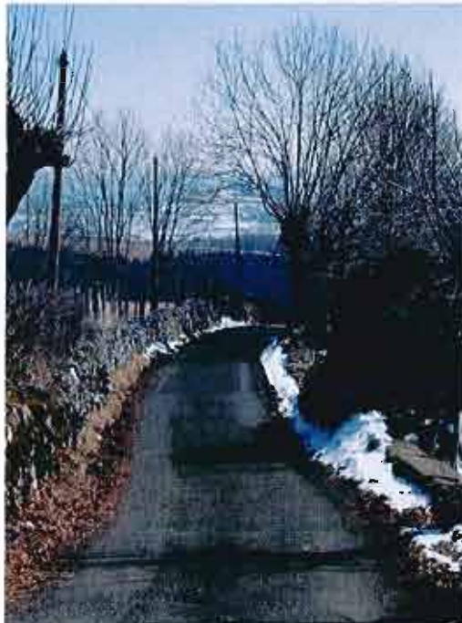
Une des nombreuses voies communales de Condom...
