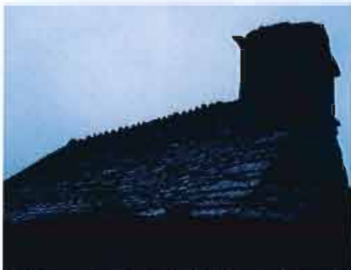
Toiture et cheminée de l'habitat traditionnel de Condom
