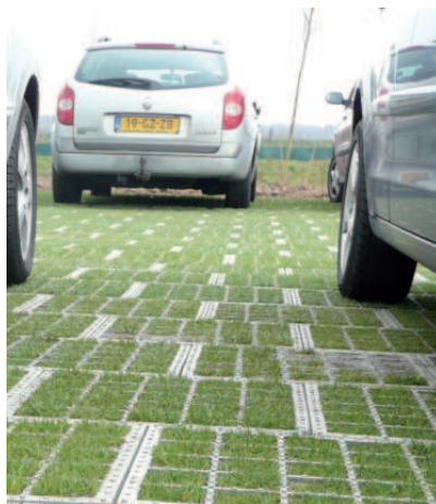
Les dalles engazonnées donnent l'assurance d'un revêtement stable, propre à supporter le poids des véhicules, sans altérer la perméabilité du sol. A droite, le Parking "vert" est recouvert de gazon fibré, et sert de bassin de rétention (Parc de la plage bleu - Val de Marne).
