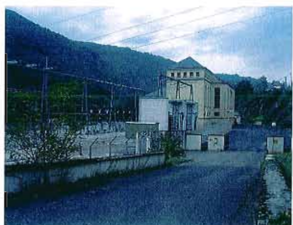
usine hydroélectrique de Lardit
