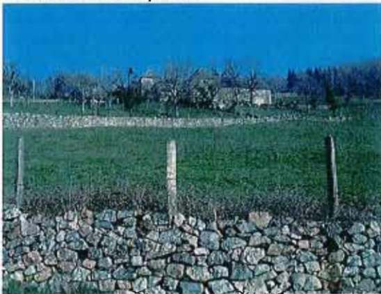
construction ancienne et murs de soutènement
