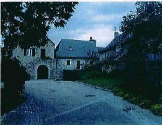
appareillage en granite à Campouriez
