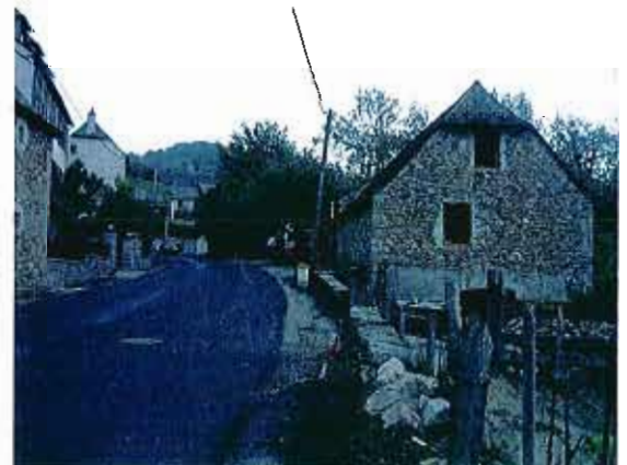
appareillage mixte à Banhars
