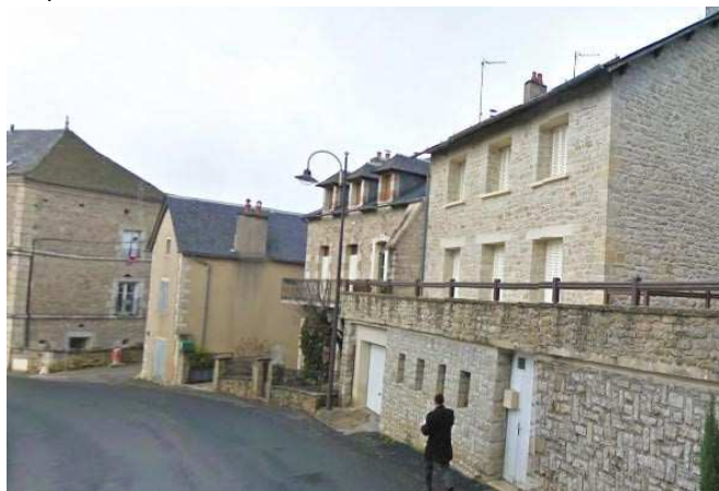
Campagnac - Façades en calcaire
