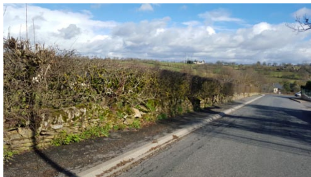
Muret bordant la parcelle 1
