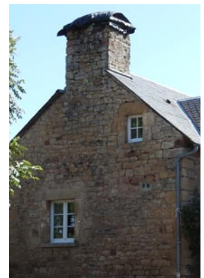
Détail de façade en pierre apparente
