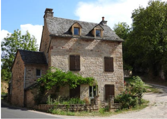
Dans l'architecture traditionnelle, les ouvertures sont généralement de forme verticale. Les dimensions et les formes sont souvent liées à la fonction de chaque pièce.
