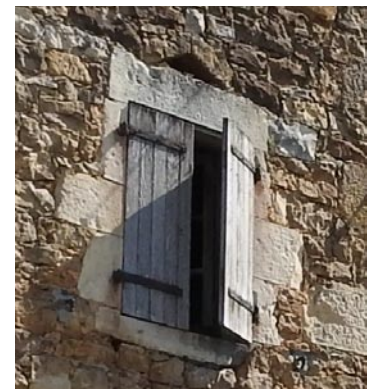
Fenêtres à l'encadrement en pierre obéissant aux dimensions, formes et couleurs de l'architecture traditionnelle
