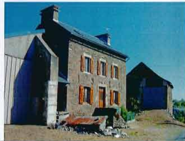
Construction La Gineste
