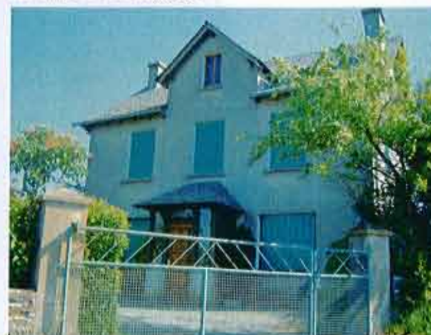
La Gineste : construction
