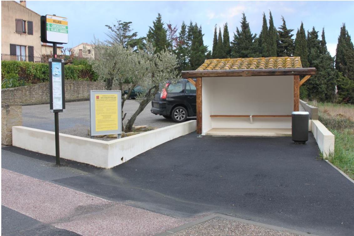
Vue d'ensemble du point d'affichage communal au niveau de l'arrêt de bus.
