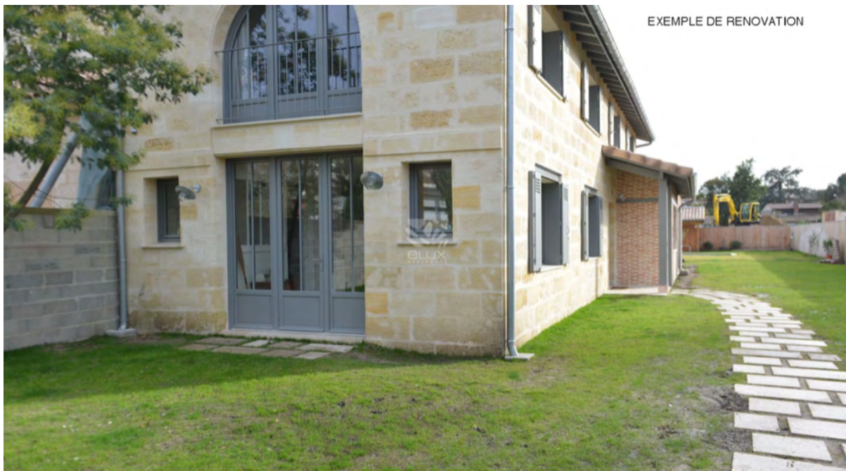
Photographie des constructions sur le site.
