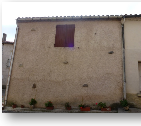
Teinte de l'enduit dans les tons saumonés qui laisse apparaître par endroit des pierres, © UrbaDoc
