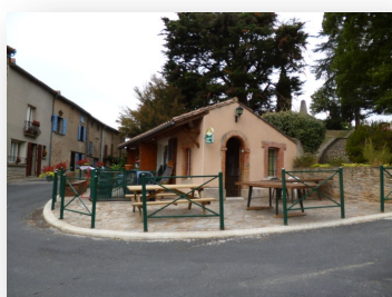
3- Accotement à hauteur du commerce séparé de la chaussée par des barrières
