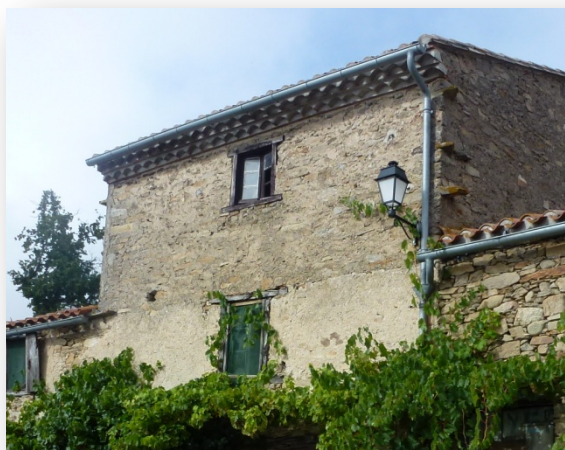
Débords de toiture sur génoise, © UrbaDoc
