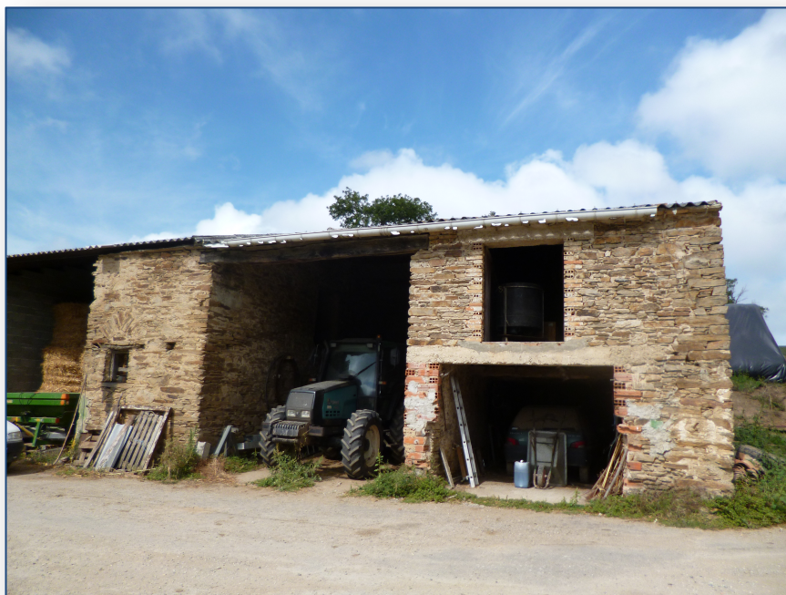
Illustration 27 : Bâtiment agricole, lieu-dit Les Trébols
