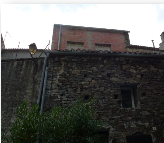
Travaux visant à augmenter le gabarit du bâti par élévation, Chemin des trois moulins, © UrbaDoc
