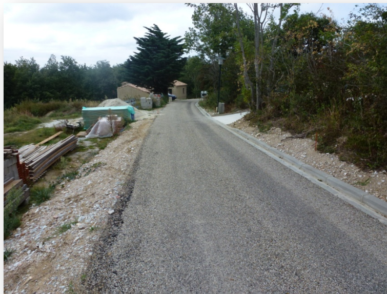
Chemin de service, secteur Pech de Bouille, © UrbaDoc
