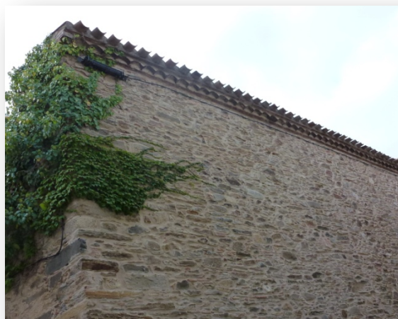
Toiture sur entablements de schiste, © UrbaDoc
