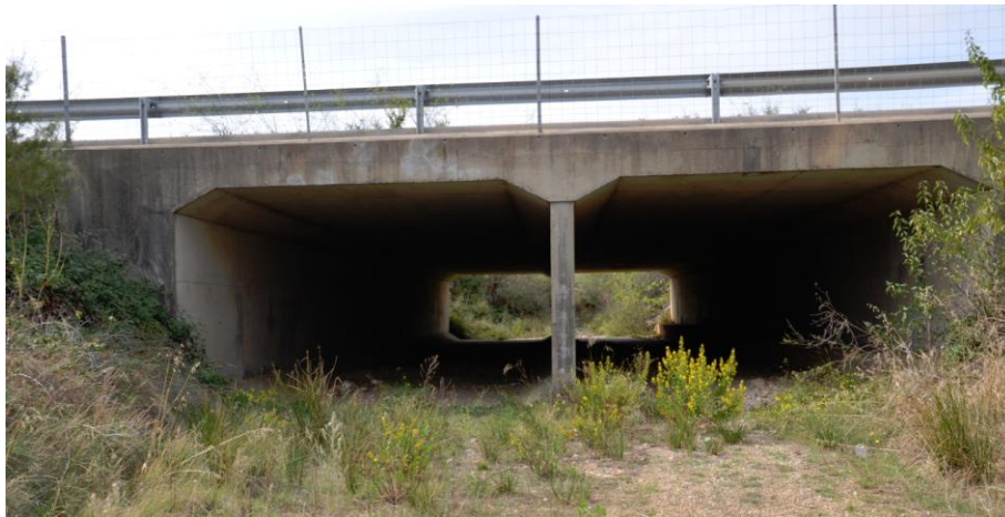
☞ Photographie : Ouvrage de franchissement sous l'autoroute A9
