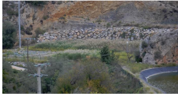
☞ Photographie : Bassins de la station d'épuration
