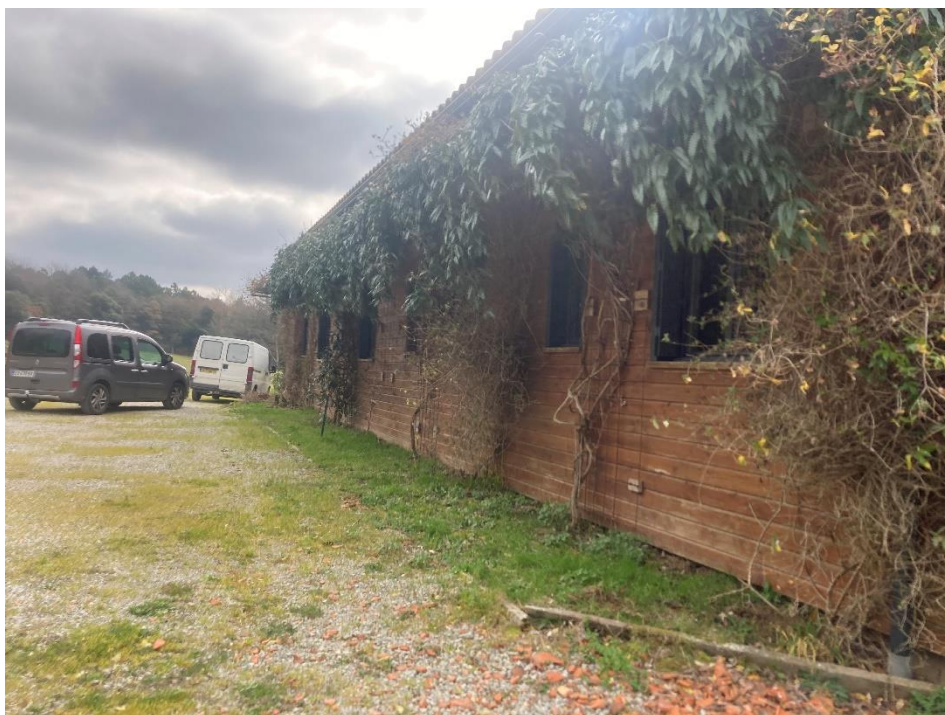
Bâtiment d'accueil existant.
