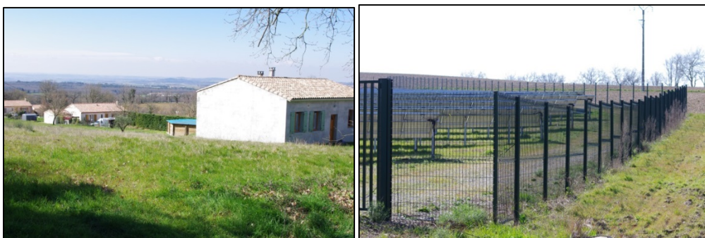
Bâtis de type moderne avec murs crépis et ferme photovoltaïque (La Pomarède, 2014) © ETEN Environnement
