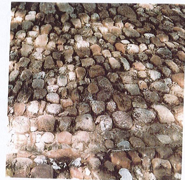
Calade drainante autour de la fontaine
