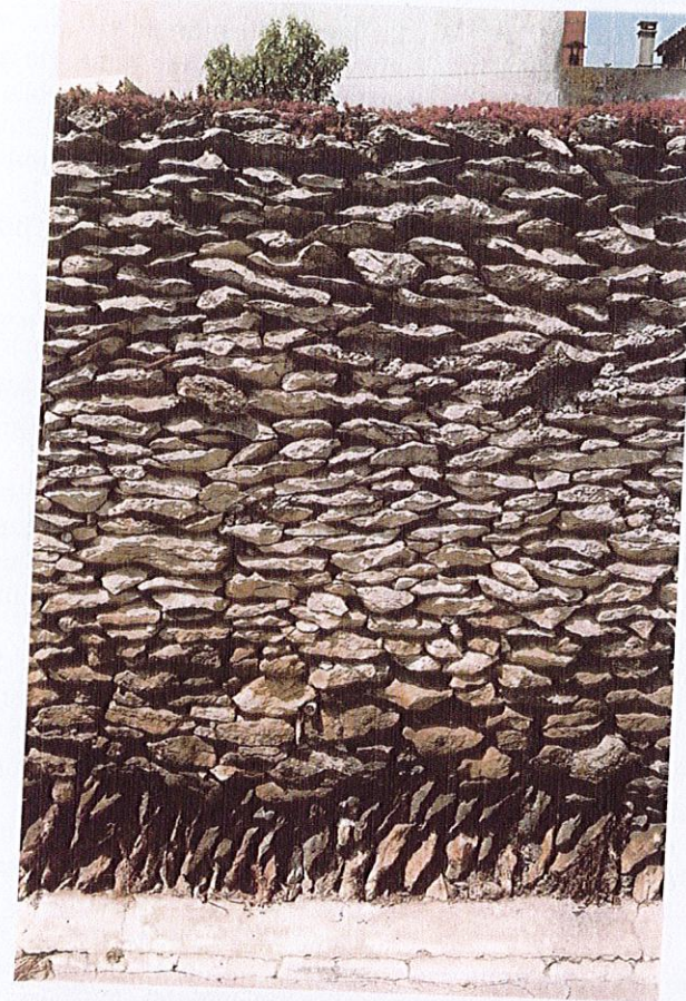
Niveau drainant en pierres verticales
