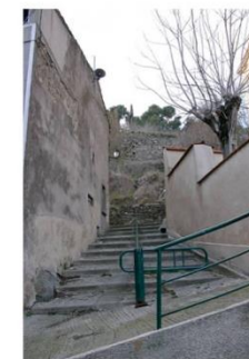
Enduit gris au ciment. Remontées d'humidité avec tâches de salpêtre (face à l'ancien presbytère)
