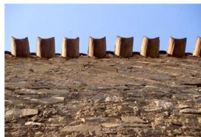
Dépassée des tuiles courantes (1, impasse du Porche)
