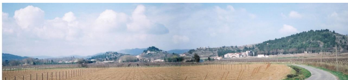
2- Façade Est depuis la route du Congoust
