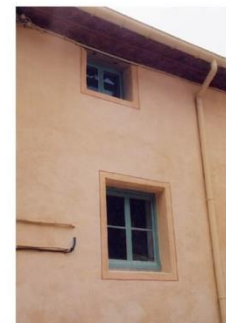
Enduit à la chaux coloré. Encadrements d'ouvertures soulignés par un filet peint (La Fraissinède)
