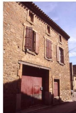
Cave avec profilé métallique soulagé, par un arc de décharge en moellons (2, rue des Monts Lauriers)
