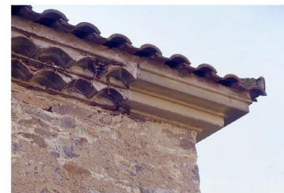
Traitement de l'angle de la génoise par une pierre moulurée (ancienne cave du château Niermans)
