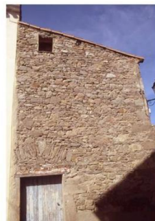
Maçonnerie apparente en moellons. Linteau en bois soulagé par un arc de décharge (12, rue des Monts Lauriers)
