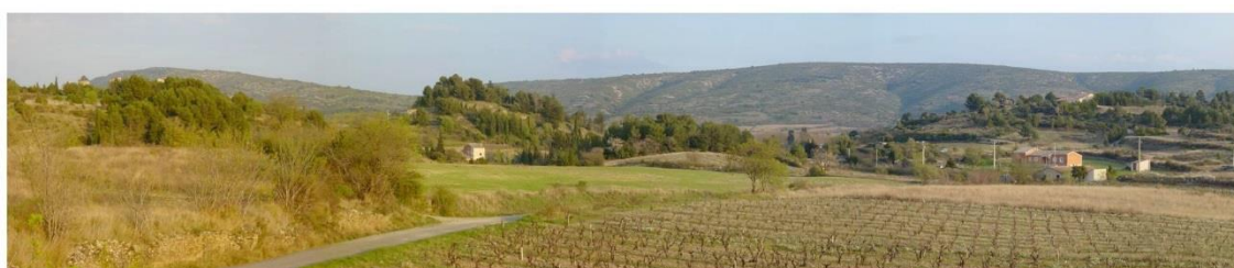
1- Façade Nord-Ouest depuis le chemin de Carcassonne
