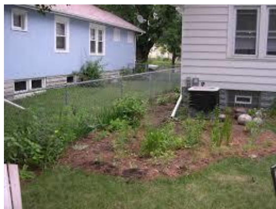
Jardin de pluie en descente de gouttière Richmond, Province du Québec
