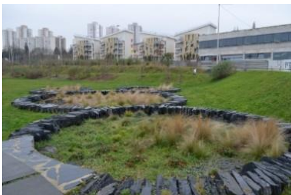
Jardin de pluie récupérant l'eau des voiries Noisy-le-Sec (Parc des Guillaumes) ©Urban Water – Christian Piel
