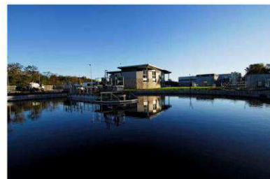
Station d'épuration Saint-Jean à Carcassonne (11)
