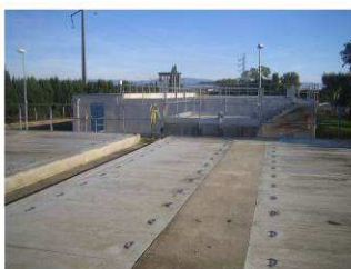
Station de production d'eau potable de Maquens (11)
