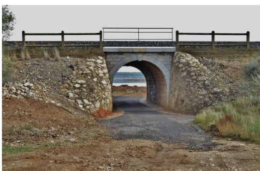
☞ Photographie : Passage routier sous voie ferrée
