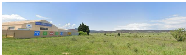
Vue Ouest depuis la route de Lézignan sur la zone artisanale et la plaine viticole
