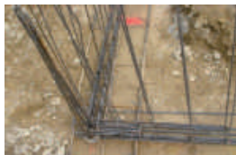
Noeud de chaînage - Continuité mécanique
