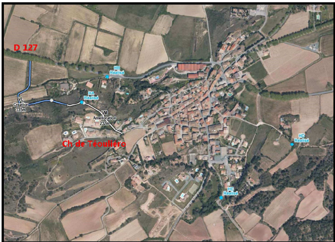
Les travaux-mesures de protection réalisés.
