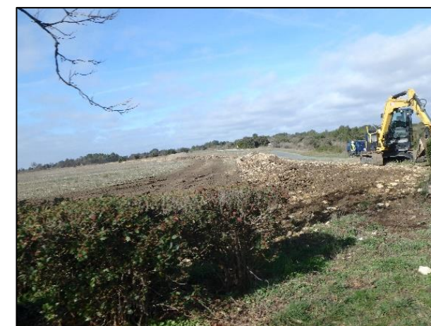
Parc photovoltaïque de Villeraze en construction
