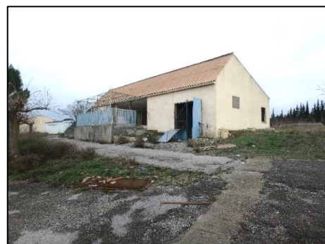
Local désaffecté dans le village vacances Source : L'Artifex 2018
