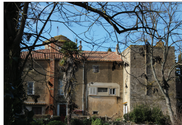
Habitat ancien à Montipèze Source : L'Artifex
