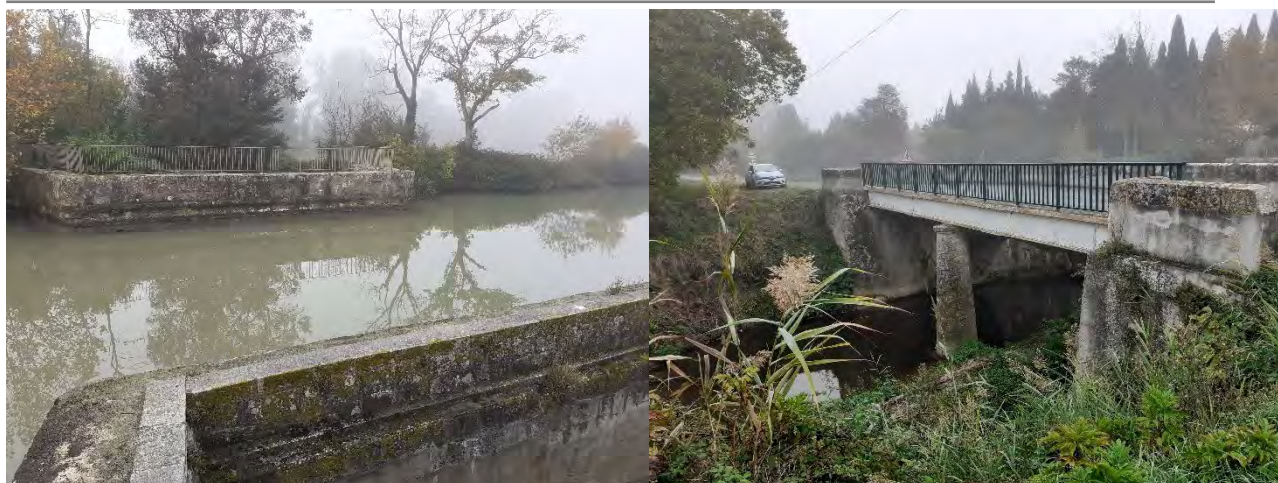
Déversoir à Villepinte sur le canal du Midi vers le Tréboul en amont du pont de la RD71
