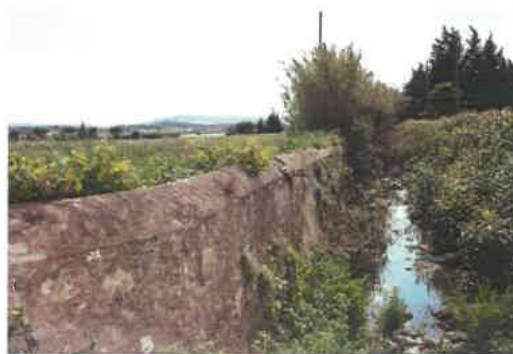
Haies, fossés de drainage et canaux d'irrigation : des éléments repères à préserver et entretenir dans la plaine.
