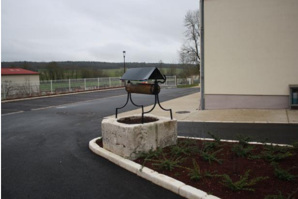
Mise en valeur d'un puits à l'arrière de la Mairie
