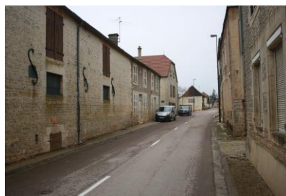
Implantation à l'alignement – vue sur site
