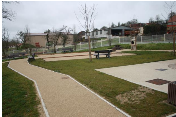
Espace aménagé à l'arrière de la Mairie
